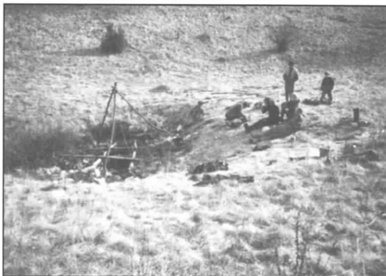
Prieipasť na Železnej lúke - dřevení nové šachty (foto F. Doležal)
