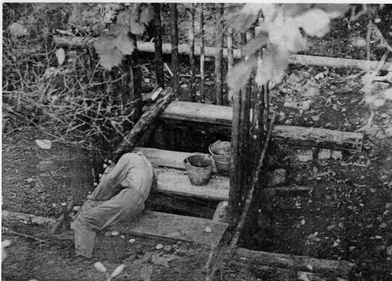
Závrt č.151 "Černý" - rekonstrukce vstupní šachty
