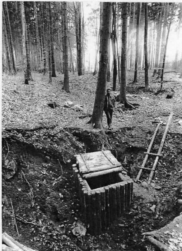
Foto: Výdřeva do Ponorného Hrádku po dokončení (1993)
