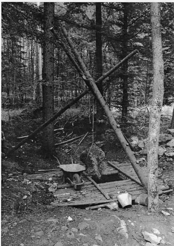
Foto: Soví komín, těžba špuntu ze skalních bloků ve Vstupní šachtě (2004).
