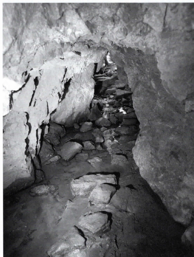
Foto 1 Výtok Řičky I – vývěrová štola (Foto I. Harna)
