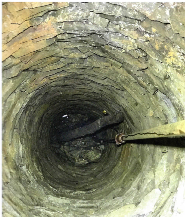
Foto 3 Bezvodá studna pod hrází Hádeckého rybníka (Foto K. Pokorný) Photo 3 A dry well under the dike of the Hádecký rybník Pond (Photo by K. Pokorný)
